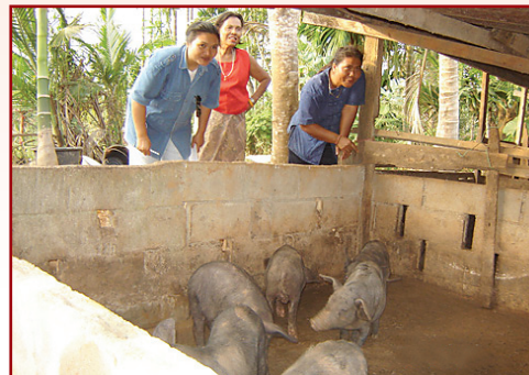
คอกสร้างแบบง่าย ใช้อิฐบล็อก เสาไม้หลังคาสังกะสีเก่า
